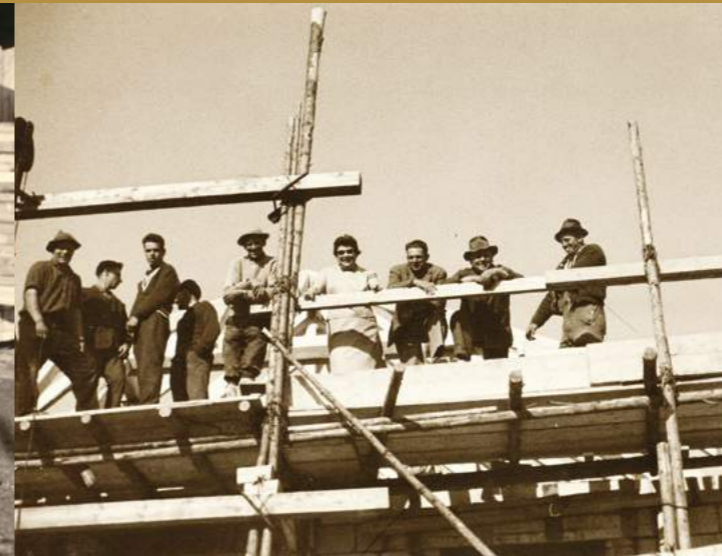
Eine verdiente Pause auf der Baustelle.
